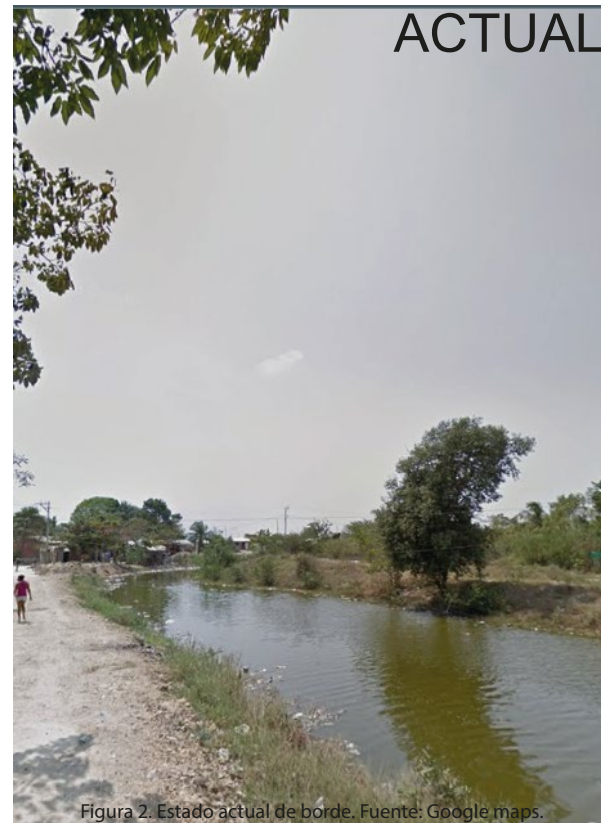
Figura 2. Estado actual de borde. Fuente: Google maps.
